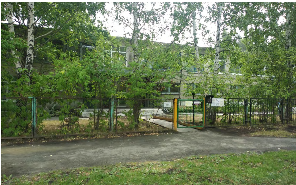
Фото 1. Главная входная группа МБДОУ № 156 (1корпус)
